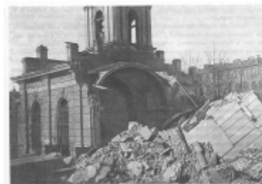
Снос Покровской церкви
